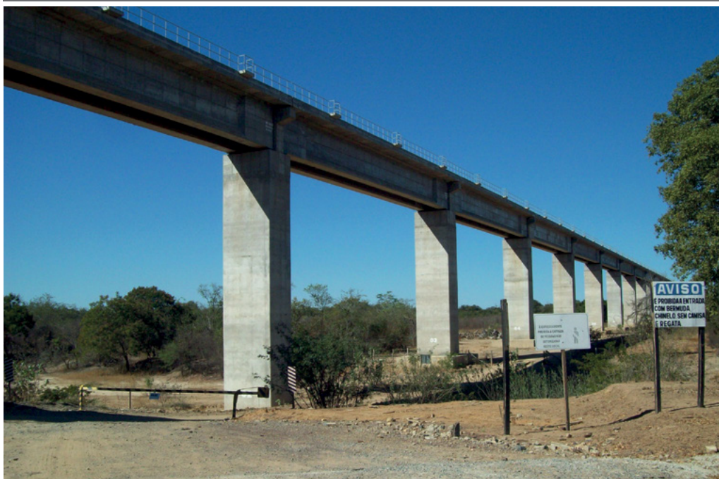
Foto 28 Obra da FIOL
