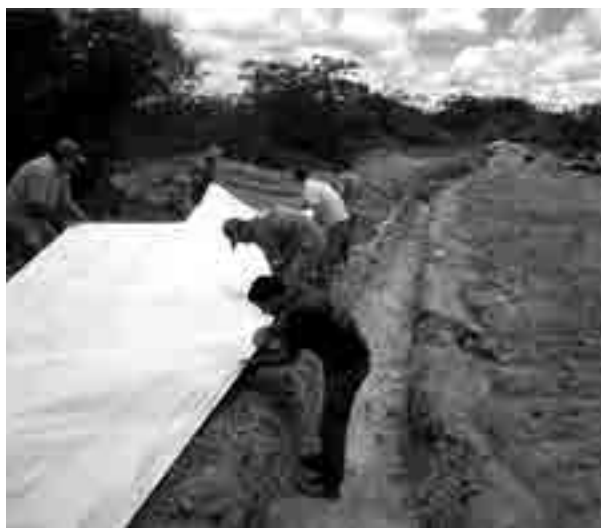
Figura 7 Barragem subterrânea no processo de montagem da lona
