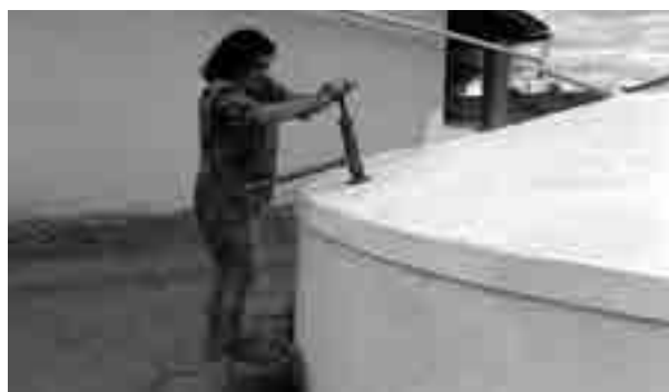
Figura 2 Utilização da bomba manual para retirada de água da cisterna
