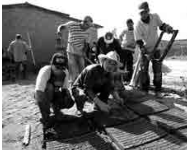
Figura 14 Construção de cisterna em comunidade do município de Manoel Vitorino (BA)
