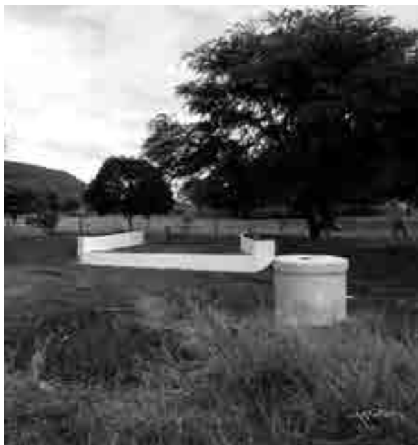
Figura 8 Barragem subterrânea pronta
