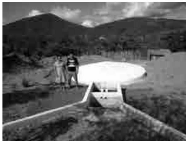
Figura 4 Cisterna de enxurrada
