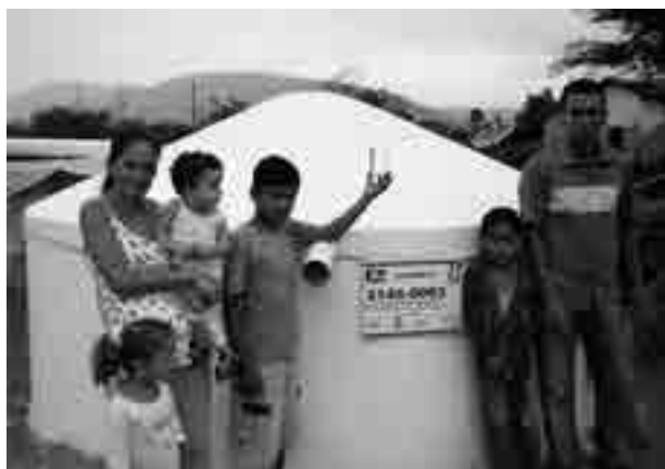
Figura 1 Cisterna de captação da água da chuva para consumo humano
