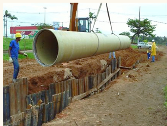
Foto 4 – Assentamento de tubulação Av. Paralela
