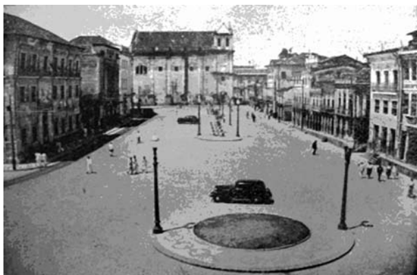
Foto 5 Praça da Sé remodelada
