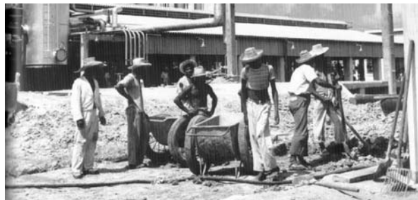
Figura 2 Trabalhadores na construção da RLAM
