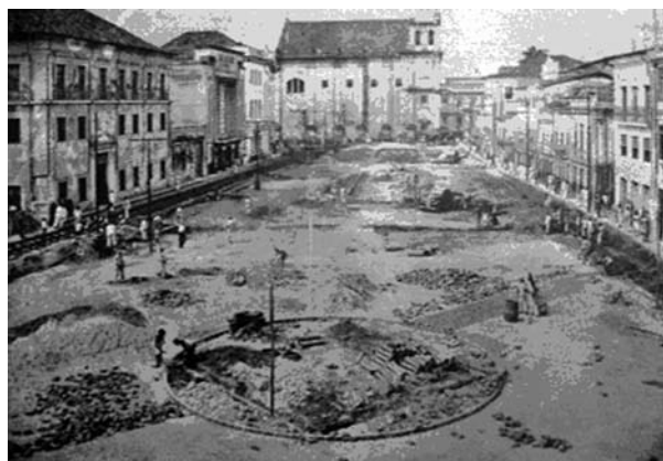
Foto 4 Praça da Sé em obras
