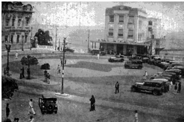
Foto 1 Praça Municipal remodelada e elevador Lacerda ao fundo
